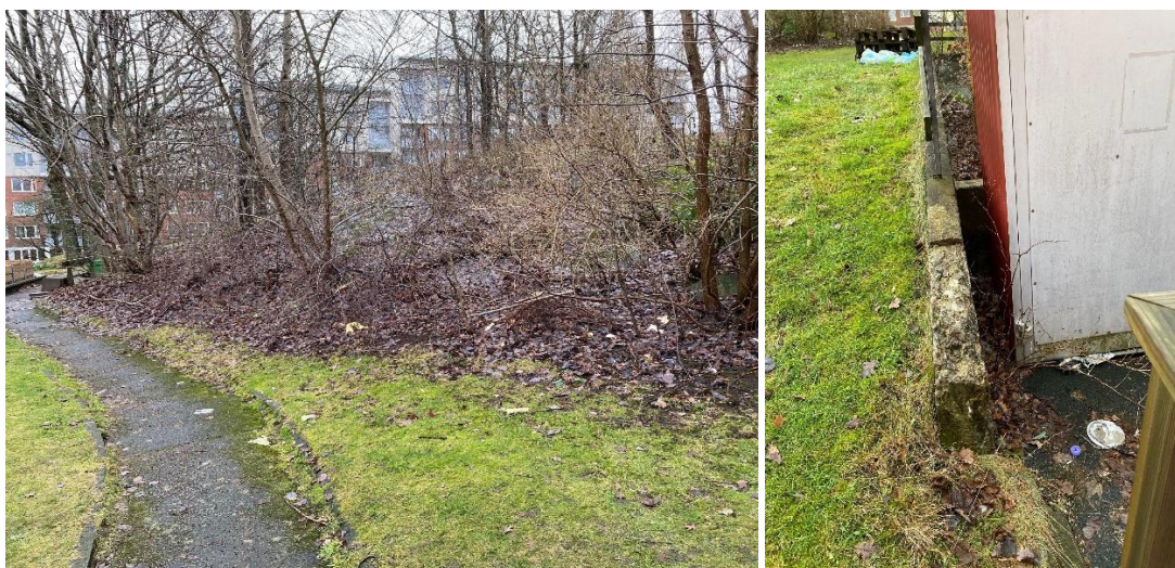
Figur 4-1 Foton över område med berg-i-dagen sydöst om fastigheten och befintlig stödmur i öst
